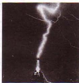
23.17 El mástil metálico de la parte más alta del edificio Empire State actúa como pararrayos. Recibe descargas de rayos hasta 500 veces al año.
